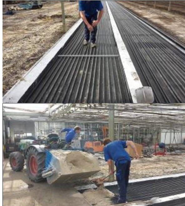
Aanleg grondslangen + gravellaag (links) Aanleg grondslang boven gronddoek + aanbrengen zandbed
