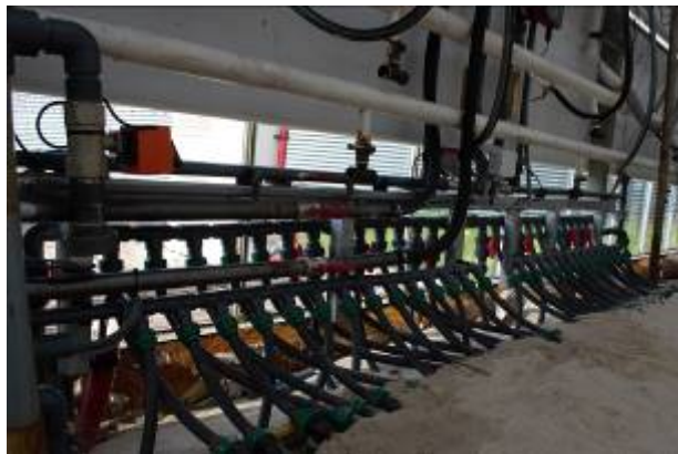
Aanleg grondslangen + gravellaag (links) Aanleg grondslang boven gronddoek + aanbrengen zandbed
