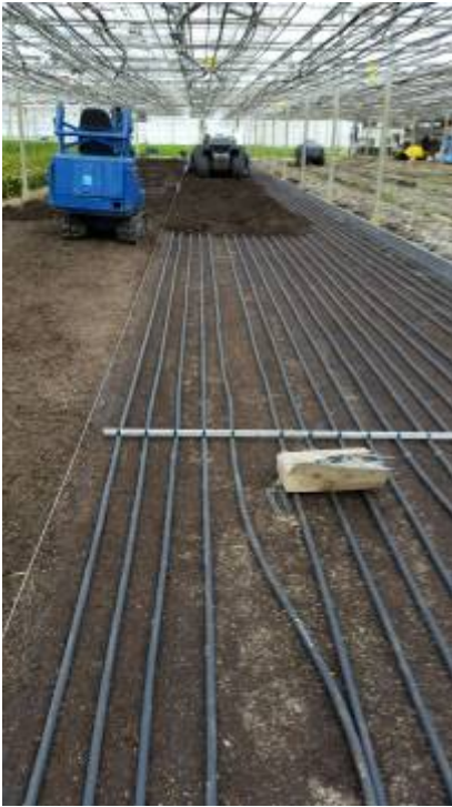
Aanleg grondslangen + gravellaag (links) Aanleg grondslang boven gronddoek + aanbrengen zandbed
